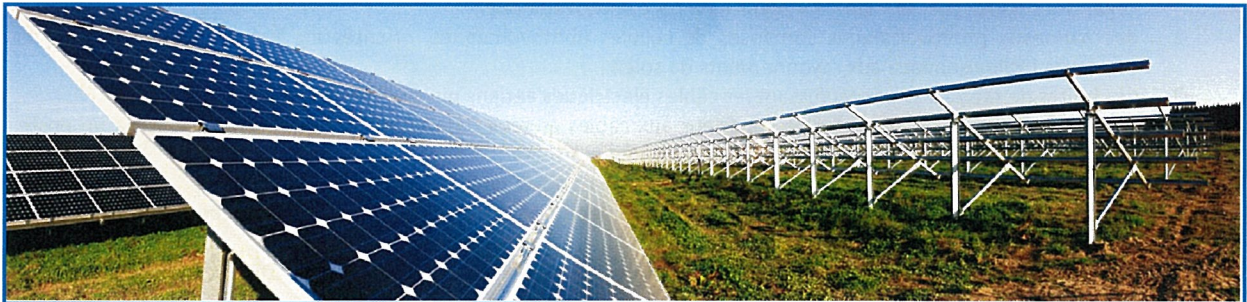
Panneaux photovoltaïques en construction
