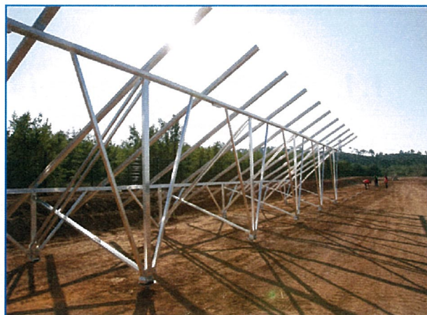
Structures porteuses pour les panneaux
