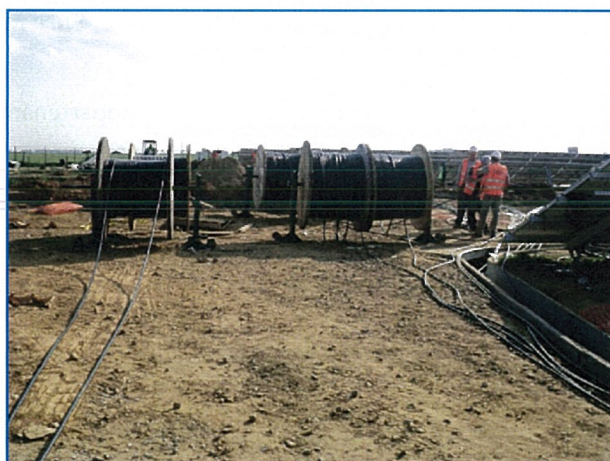
Enterrement du réseau électrique
